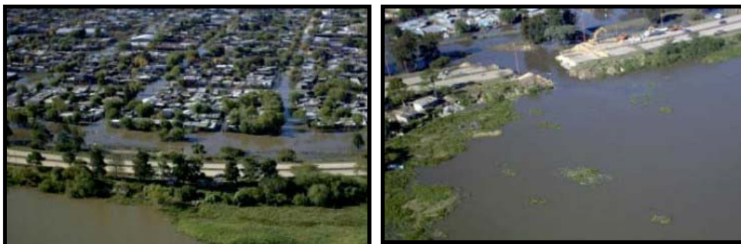
Anegamiento y corte de terraplén en barrio Centenario
